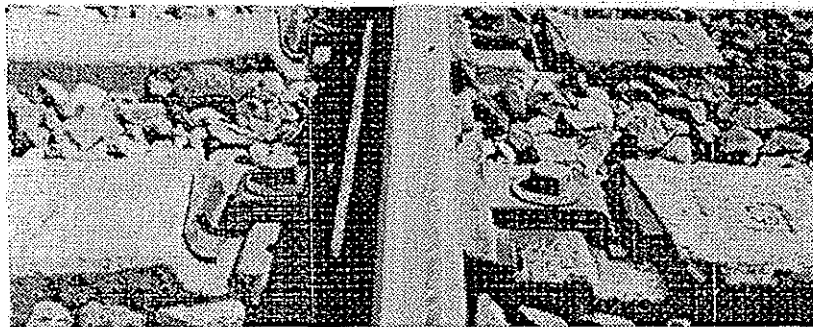
Gambar 4.17c Penambat F-type pada bantalan beton
