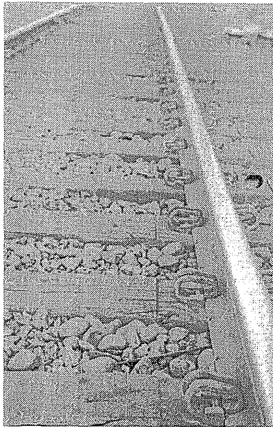
Gambar 4.12c Penambat Elastis DE pada bantalan kayu; Tanpa Pelat andas
